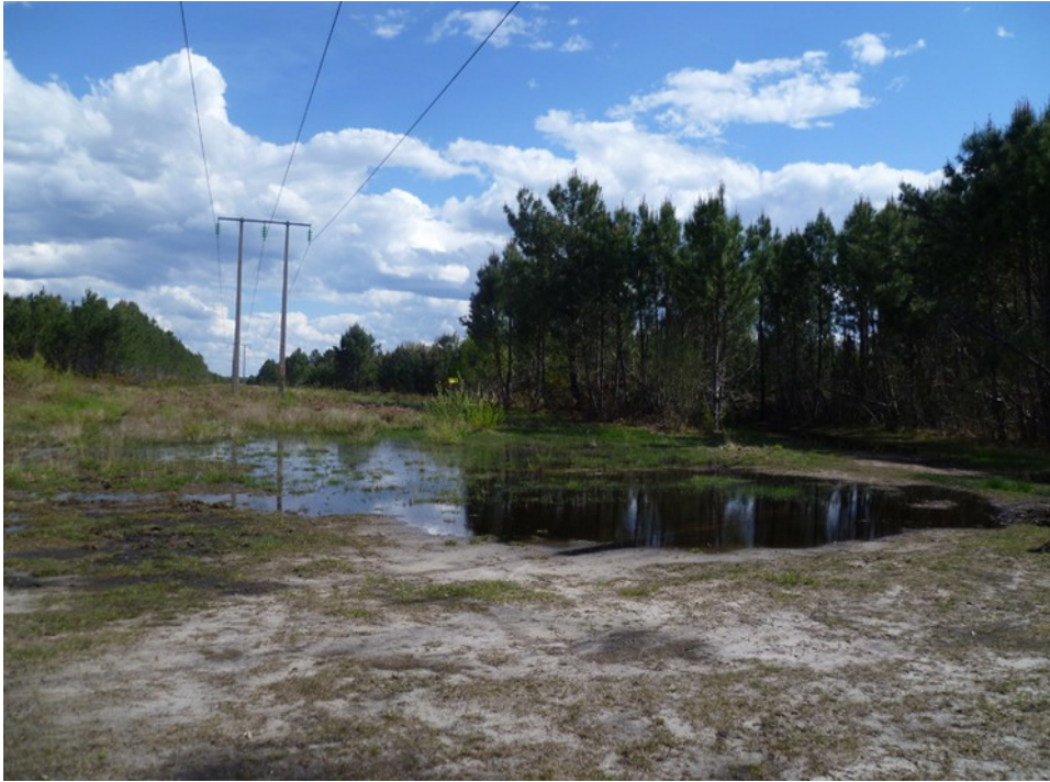
Affleurement de la nappe phréatique dans des secteurs peu drainés par le réseau de crastes et fossés
